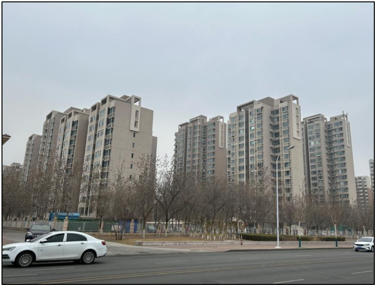
图 3-5 富民里现状照片
