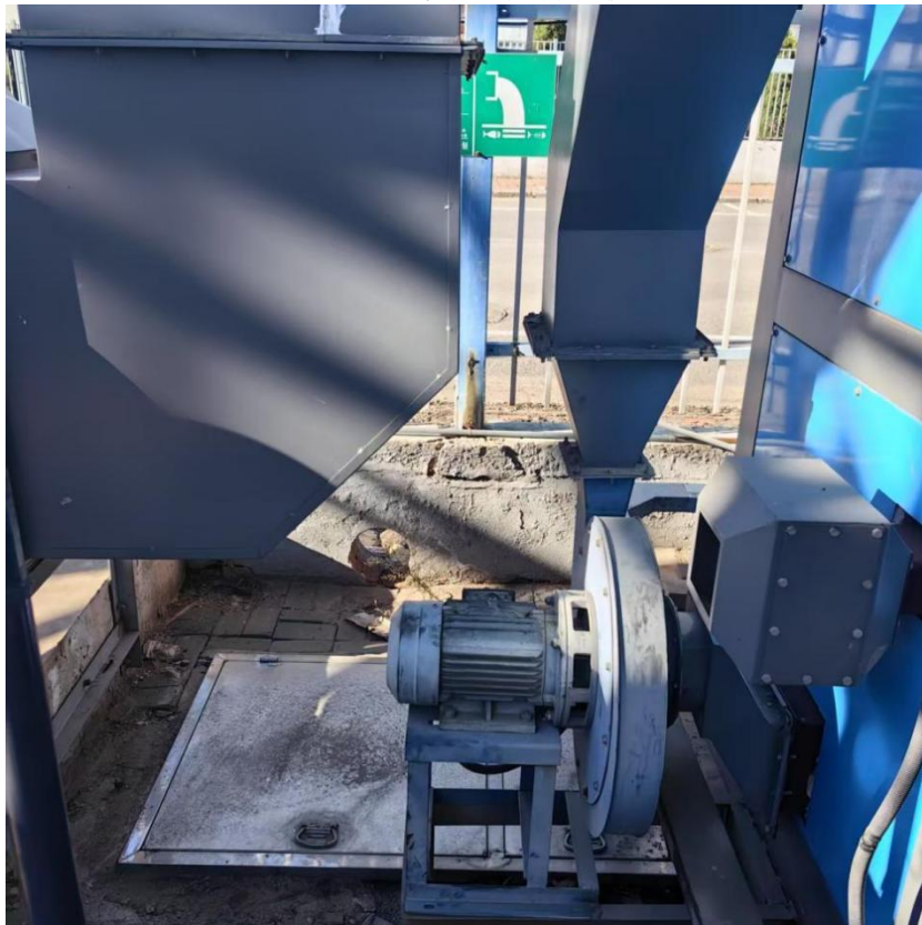
图 2-6 共用污水总排口现状
