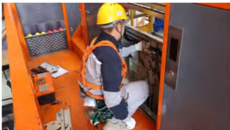
图 3-5 2025 职业院校技能大赛“电梯维修与保养”项目
